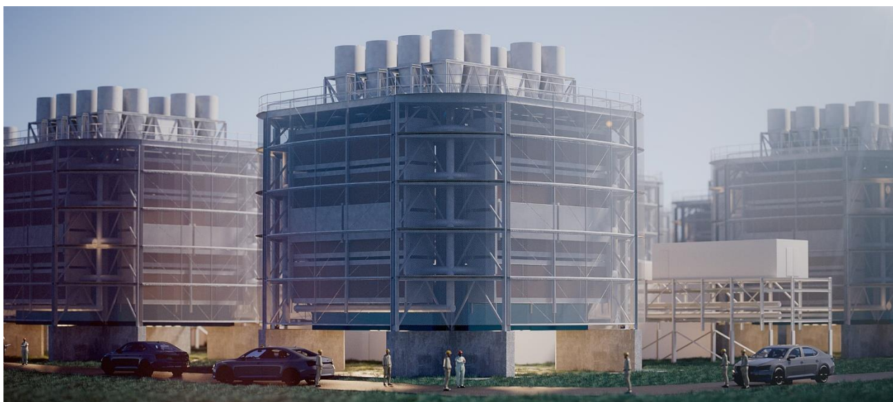
第3世代の直接空気回収技術のベースはモジュール式のキューブに収納された新構造の吸着材
